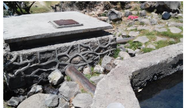
c) Caja que transporta el agua a la zona de bombeo
