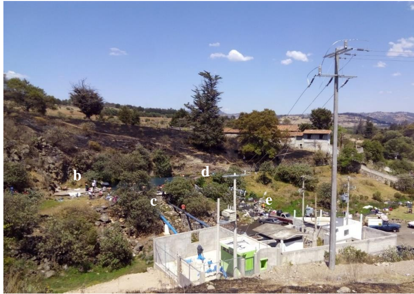
a) Panorámica de la captación del manantial
