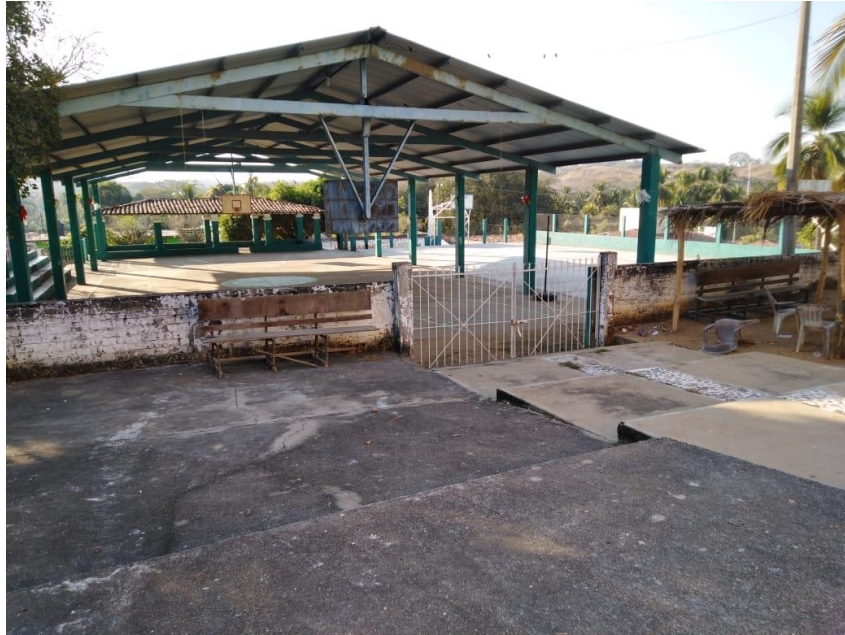
Fotografías 14 Vista del salón de usos múltiples desde la iglesia.
