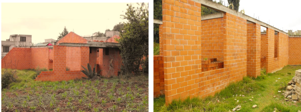
Figura 8. Construcción inconclusa del CAO Yapanigui
