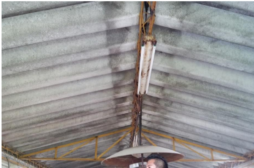
Figura 13. Techo de la nave
