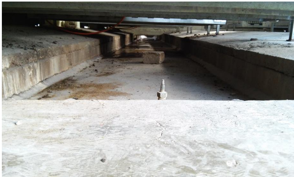
Figura 14. Canal de excremento y orina
