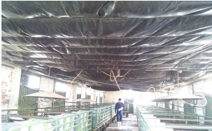
Figura 17. Techo de la nave de destete
