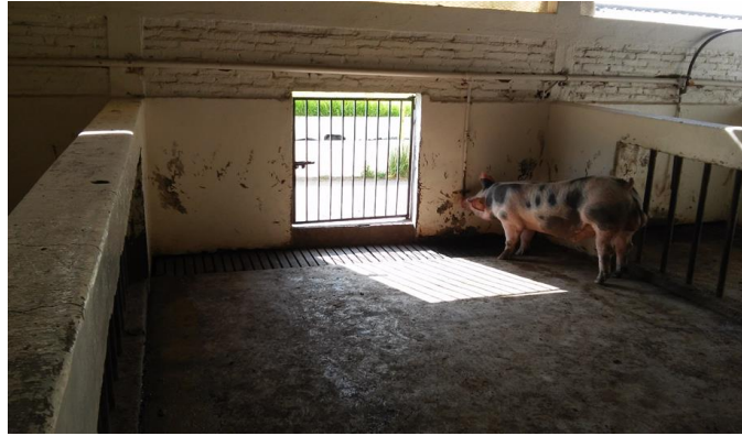
Figura 20. Puertas de acceso no requeridas
