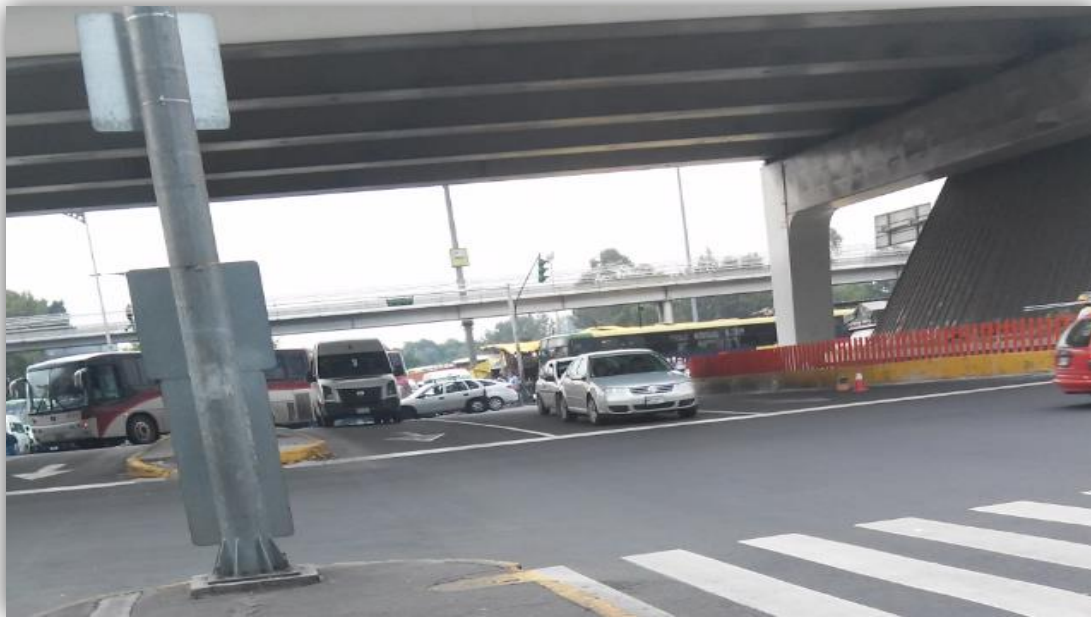
Ilustración 2. Problema de congestionamiento en la intersección Circuito Interior ocasionado por los semáforos en la Calzada General Ignacio Zaragoza.
