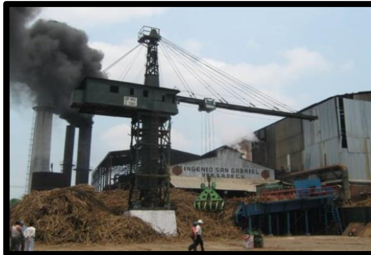
Figura 3 Grúa de descarga de caña. Extraído de internet autor NORAALBA 2017
