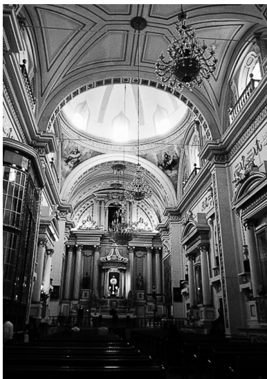
» Imagen 3: Interior neoclásico del templo conventual del ex convento de la Limpia Concepción, Puebla.
