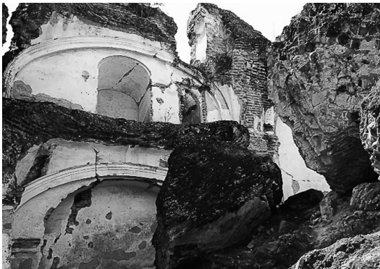
» Imagen 1: Destrucción del templo del convento de Capuchinas en Antigua Guatemala.
