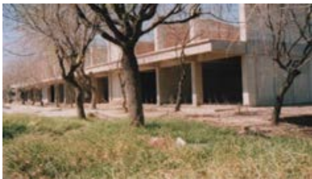
Instalaciones del edificio de la Escuela de Antropología (Autor Anónimo, 1991. Acervo de la Facultad de Antropología)
