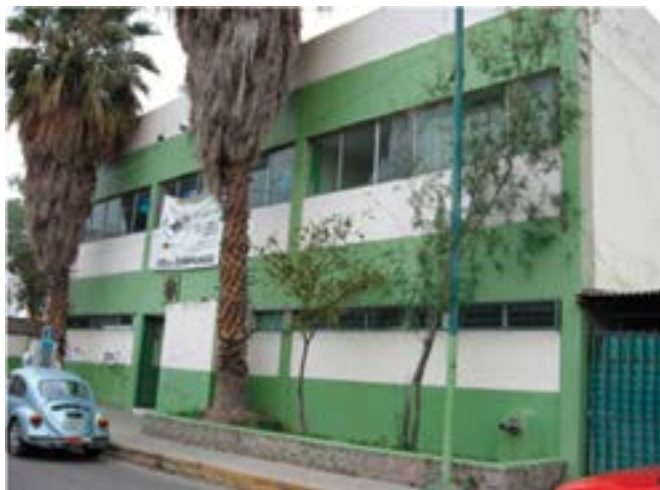
Edificio que fuera un hospital y que la UAEM adquirió para ampliar los espacios requeridos en 1989.
