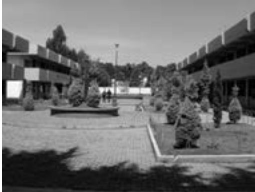
Vista de los edificios A, B, C, y D
