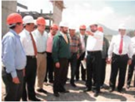
El director de la obra explica los avances constructivos (Leopoldo Basurto Hernández, 2012. Acervo de la UAP Huehuetoca)
