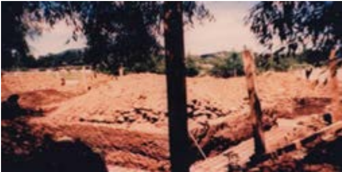
Inicios de la construcción del edificio de la Escuela de Antropología (Autor anónimo. Acervo de la Facultad de Antropología)
