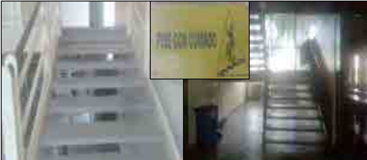
Fotografía 45: Pisos y escaleras lisas ; Campus Los Uribe; UAEM
