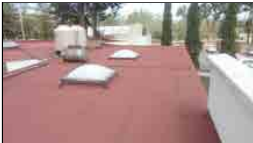
Fotografía 12: Tanque de almacenamiento de Gas L.P en un edificio del CELE; Ciudad Universitaria; UAEM
