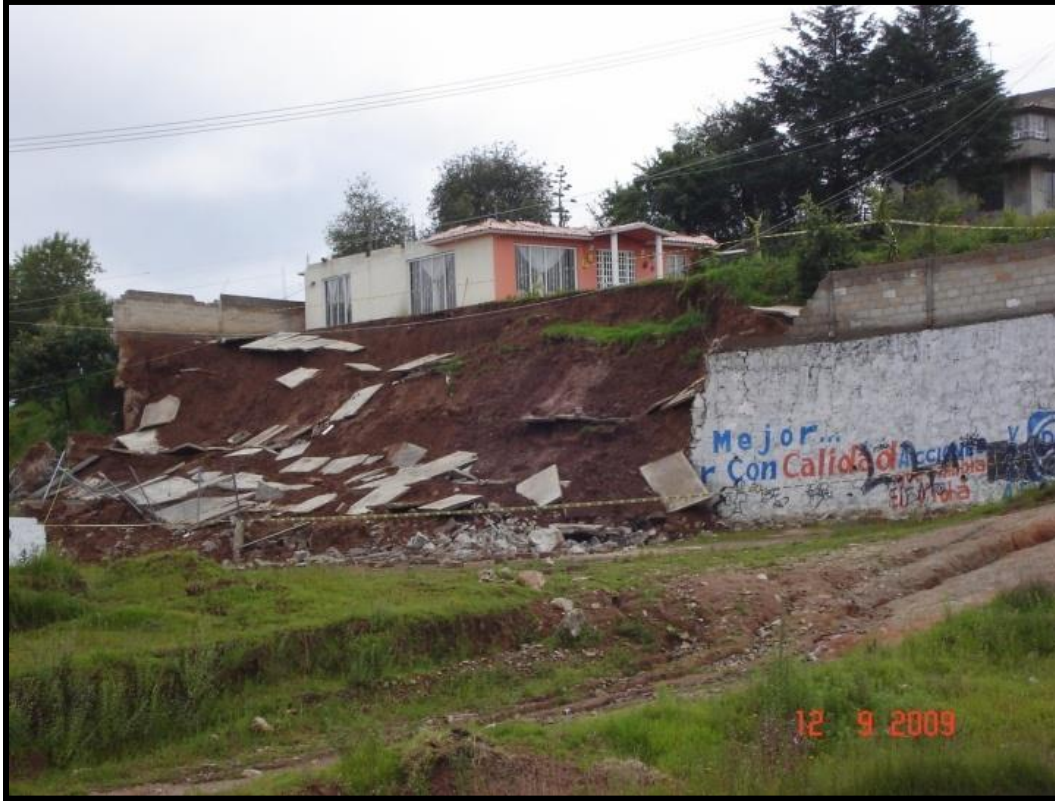
Figura 4.2 Afectación de un espacio esencial ocupado por una casa. El geosistema es un deslizamiento ocurrido en casa habitación que afectó la entrada y patio de la vivienda en el barrio La Garita.
