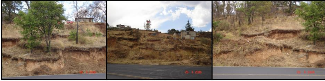
Figura 3.6 Deslizamientos de serie única y terrazas de deslizamiento en diferentes sectores de la localidad de Santa María Zolotepec.
