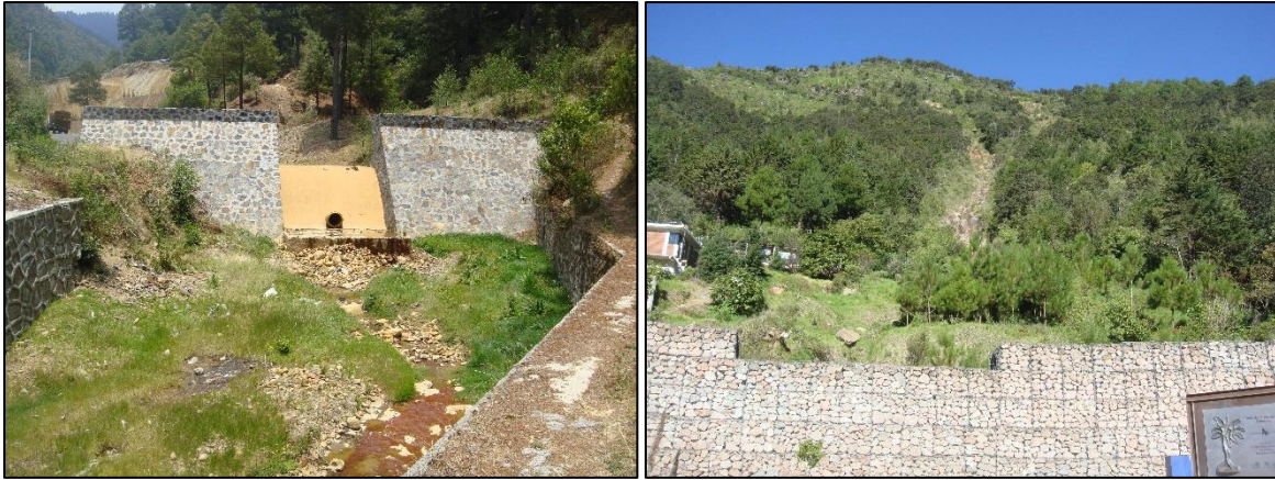
Figura 5. 2 Medidas estructurales construidas en el municipio de Angangueo; entre ellas muros de mampostería localizados en el barrio de Cantingón (izquierda) y presas de gaviones, construidos en el barrio del Sauz (derecha). Fuente: Trabajo de campo (2016).
