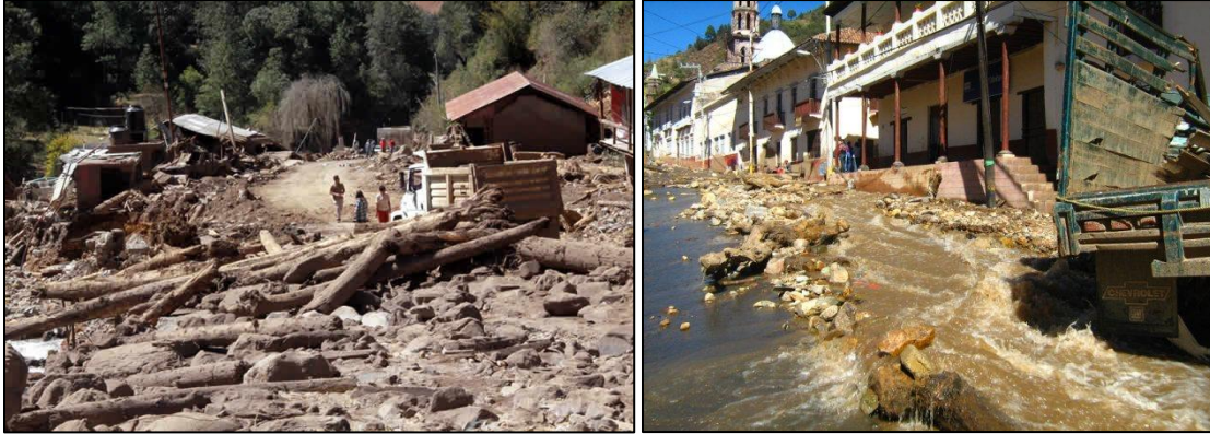
Figura 4. 6 Viviendas afectadas por flujo de detritos y lodo localizados en el Barrio de San Pedro (izquierda) y la Colonia Centro (derecha). Fuente: El universal (Alvarado, 2010); García J., (2012).
