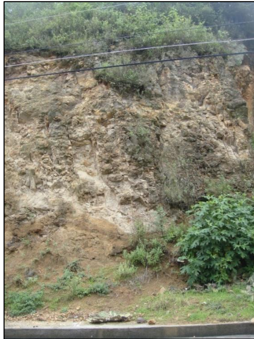
Figura 4. 13 Caída de rocas en la colonia Segunda de Juárez. Fuente: Trabajo de campo (2016)
