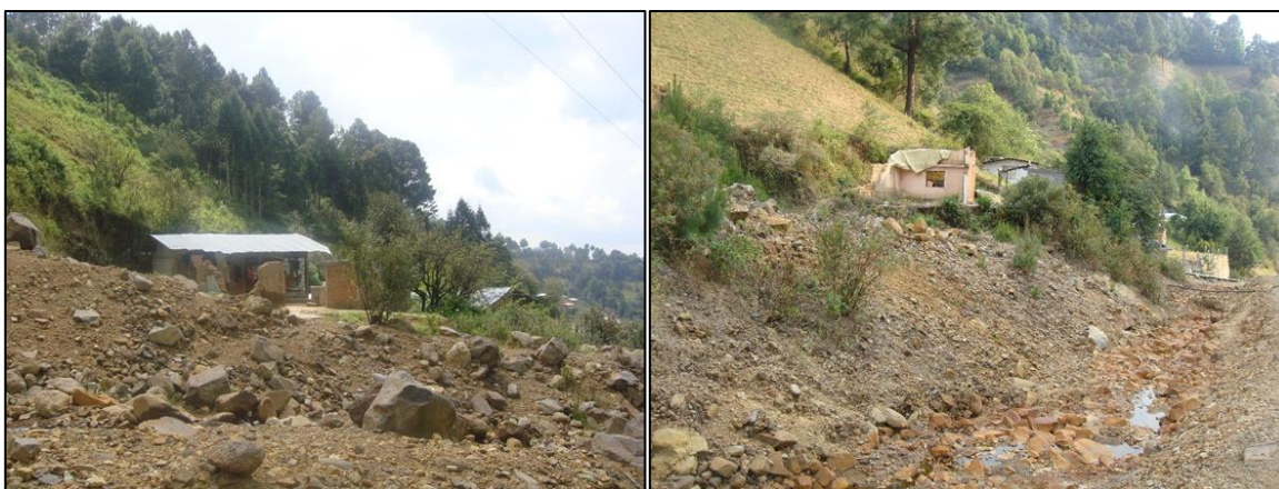
Figura 4. 9 Fotografías que muestran daños en la infraestructura urbana ocasionados por flujos de detritos y lodo, localizados en la localidad de El Tigre (izquierda) y el barrio de San Pedro (derecha). Fuente: Trabajo de campo (2015 y 2016).
