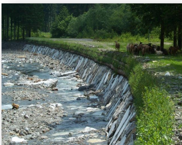
Figura 9. Ejemplo de escollera sobre un cauce.
