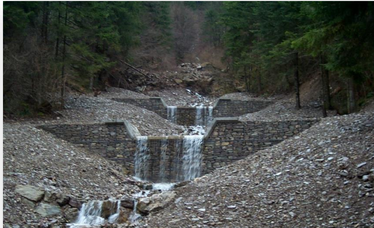
Figura7. Ejemplo de dique de consolidación
