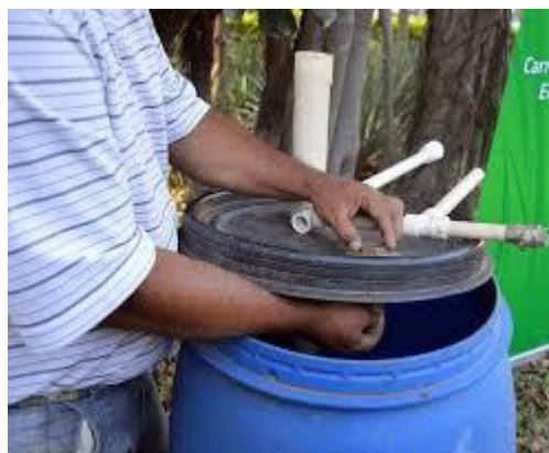
Figura 23. Instalación de la tubería de gas (Javr, 2014).
