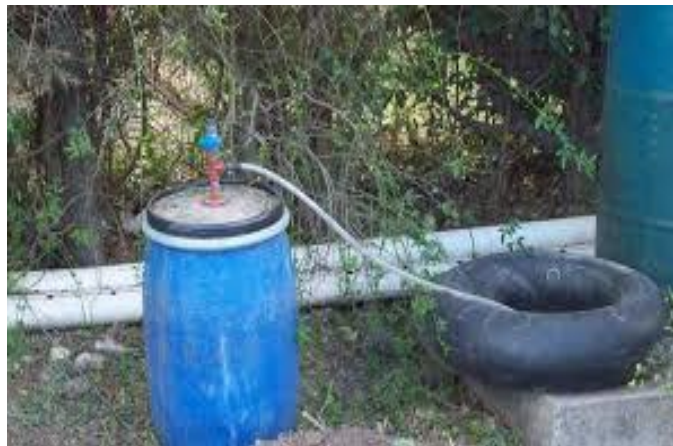
Figura. 14. Biodigestor tipo Olade Guatemala (Londres, 2016).
