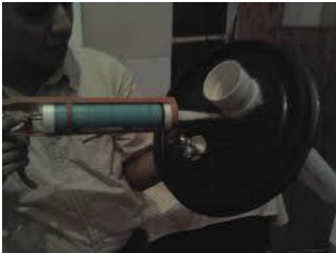
Figura 24. Sellado del tubo de carga (Londres, 2016).
