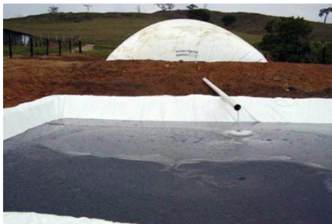
Figura 19. Pila de descarga (Vasker, 2009).
