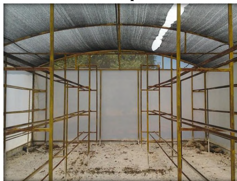
Fotografía 12. Interior del módulo tipo 2
