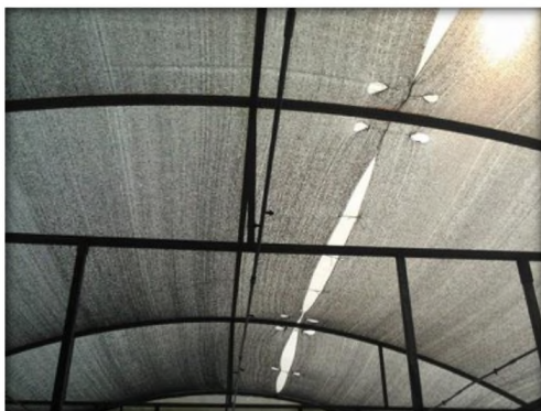
Fotografía 13. Aspersores y techo de malla sombra
