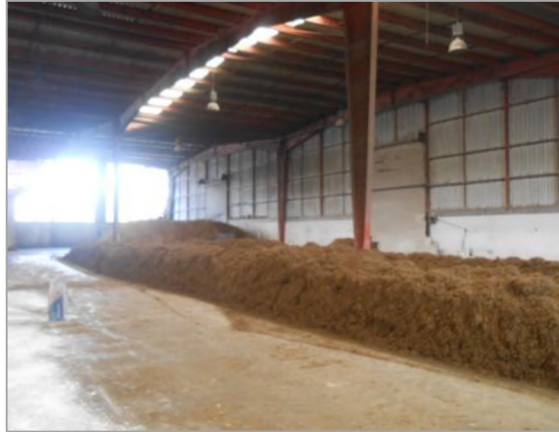
Fotografía 3. Camellones de composteo.
