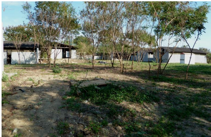
Figura 4. Campamento para los trabajadores de IBEROSTAR, Litibú, 2008
