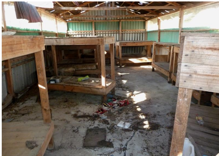
Figura 6. Instalaciones del campamento para los trabajadores de Iberostar, Litibú, 2008
