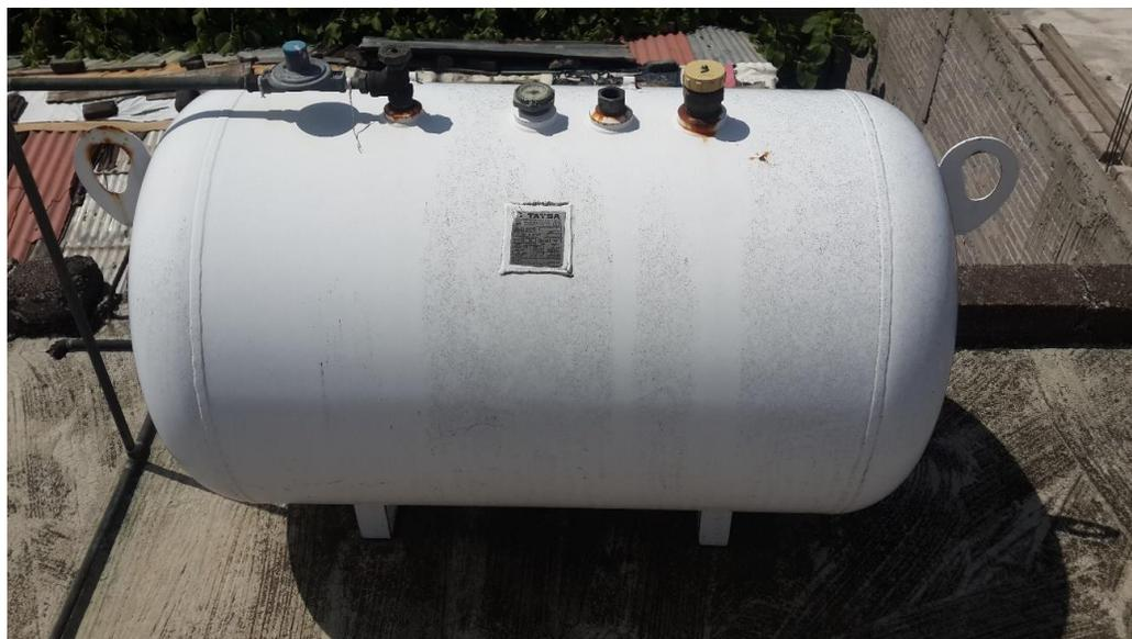
Figura 19 Tanque de gas estacionario. Fuente propia
