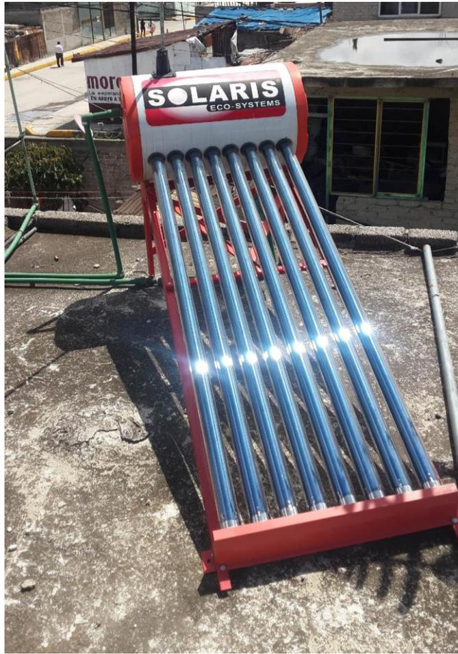
Figura 22 Calentador solar para agua. Fuente propia
