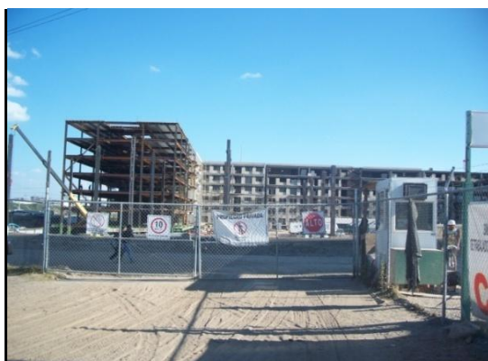
FOTOGRAFÍA 4.- CONSTRUCCIÓN DE LA VILLA PANAMERICANA
