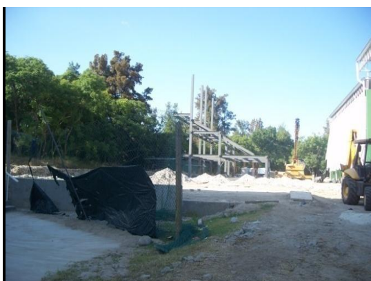
FOTOGRAFÍA 10.- REMODELACIÓN DE INSTALACIONES
