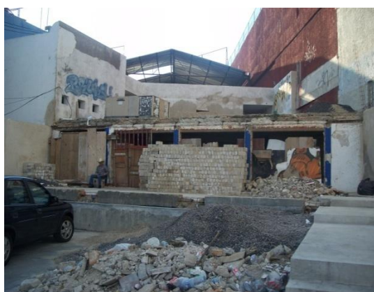
FOTOGRAFÍA 2.- REMODELACIÓN DE PREDIOS
