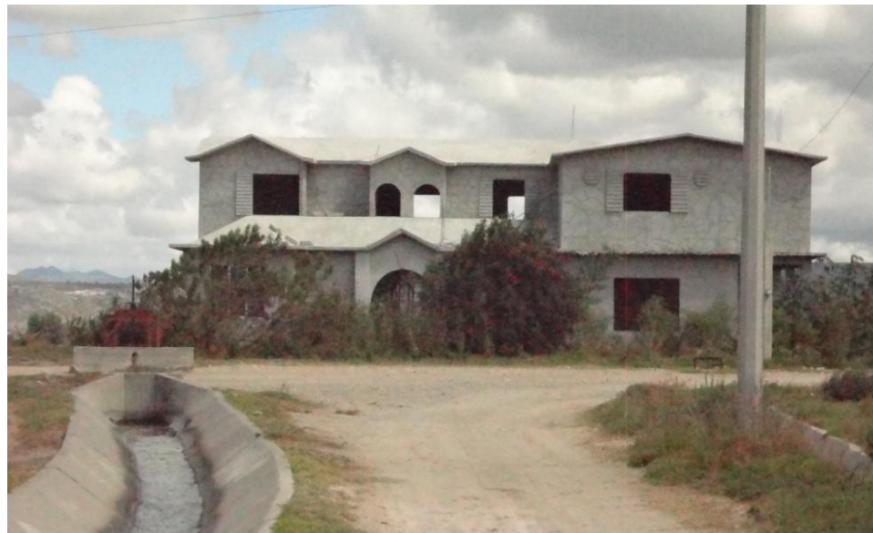
Fotografía 4. Vivienda en obra negra (foto tomada por THM, 2012)
