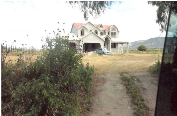
Fotografía 5. Vivienda en obra negra (foto tomada por THM, 2012)
