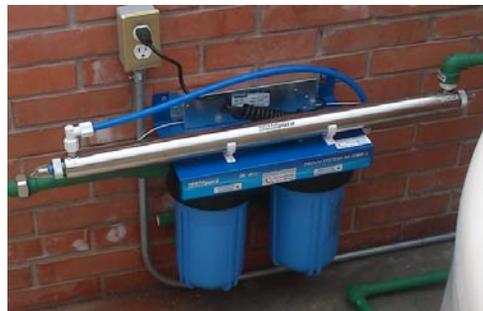
Zona de Toluca: INSTAPURA; Equipo purificador de agua por medio de luz ultravioleta PROUV-SYSTEM-24-10BB-1 127V ~ 21W 50 ó 60Hz
