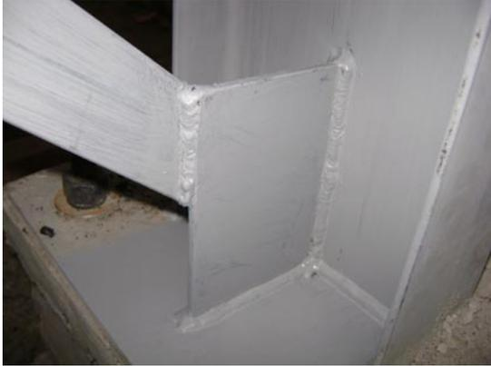
**Figura 15 Placas en columna parte inferior.**
