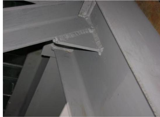
**Figura 16 Placas en columna parte superior.**
