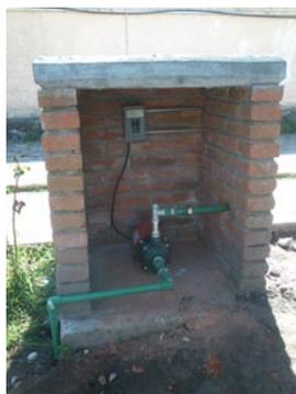
Figura 22 Cárcamo con ventilación para alojar la bomba y tablero de control.
