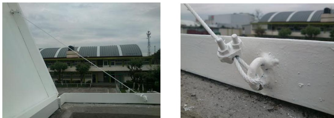
Figura 21 Mecanismo a prueba de sobre apertura de tapas.
