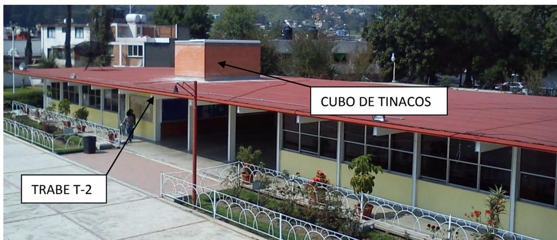
Figura 1 Cubo de tinacos sobre trabe T-2 en edificio U-1C.
