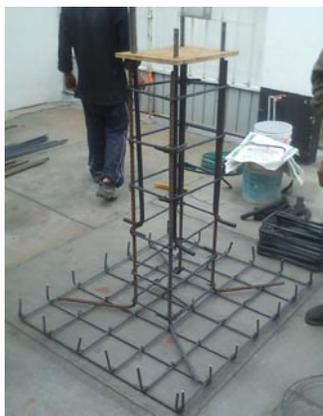
Figura 7 Armado de zapata y dado o pedestal de 30 X 45 cm.
