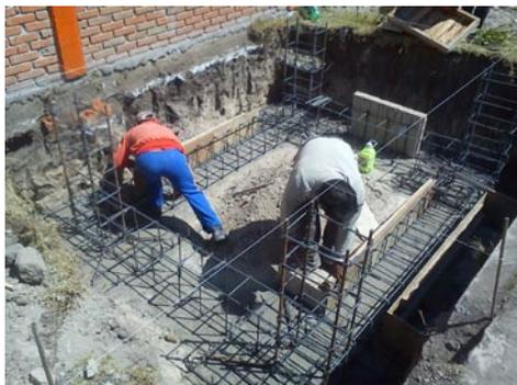
Figura 8 Armado de zapatas y traveses de liga.
