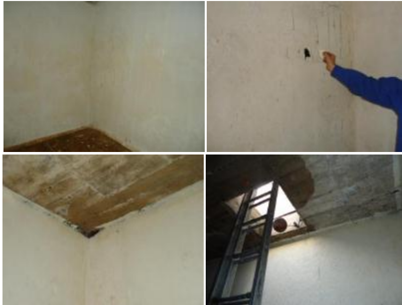
Figura 6.17 Estado de cisternas No.2 (Elaboración Propia)
