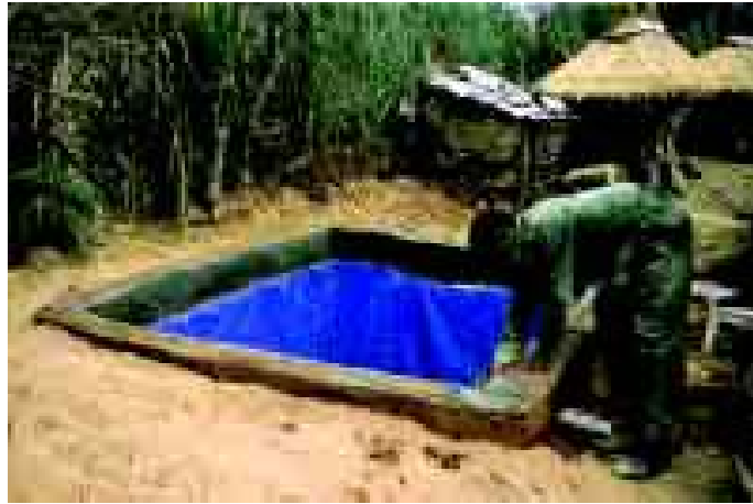
Figura 2.10 Construcción de tanque con polietileno (Nega y Kimeu 2012)
