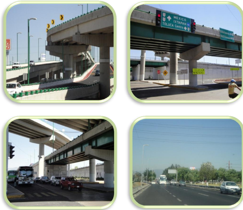
Fotografía 27, 28, 29 y 30. Vialidad Paseo Tollocan
