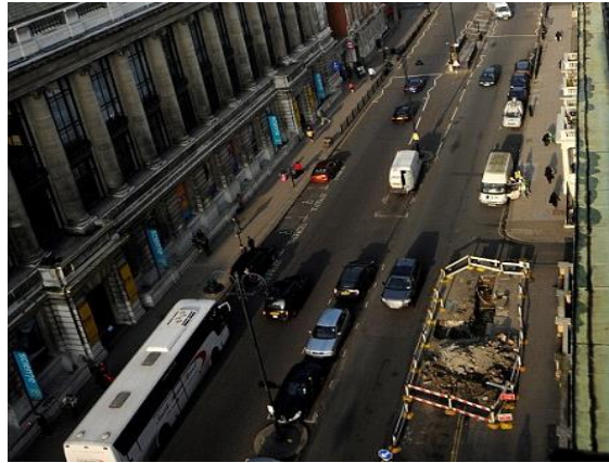
FUENTE: PORTAL CIUDAD OBSERVATORIO
