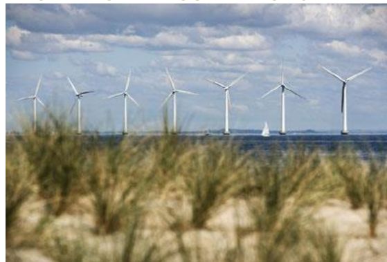
IMAGEN 11. COPENAGUE, ABASTECIMIENTO DE ENERGÍA POR MEDIO DE AEROGENERADORES
