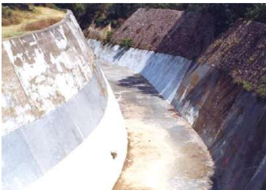
Figura 4.7. Canal de descarga del vertedor.
