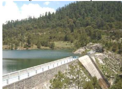
Figura 4.13. Cortina de la presa.
