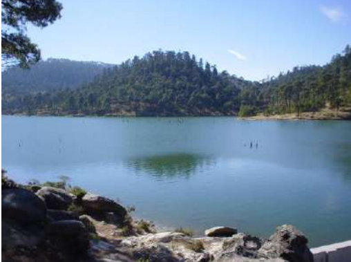
Figura 4.10. Panorámica agua arriba de la presa.
