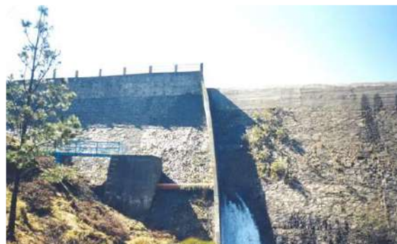
Figura 4.15. Descarga de la Presa Iturbide.
