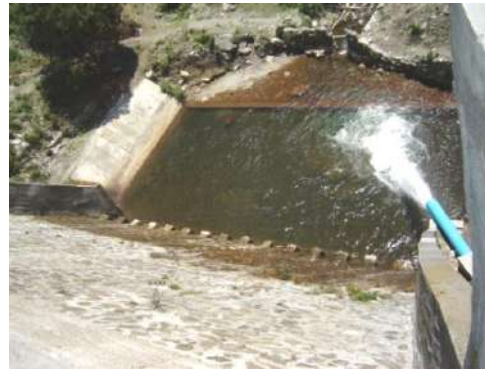
Figura 4.11. Vista aguas abajo de la cortina.
