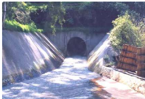
Figura 4.8. Obra de salida de la toma en margen derecha.
