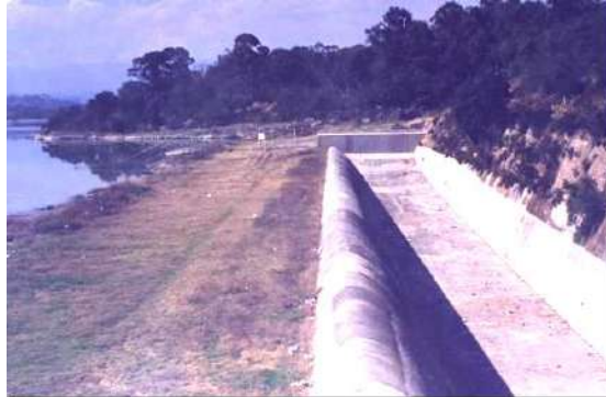
Figura 4.6. Vertedor de canal lateral en la margen izquierda.
