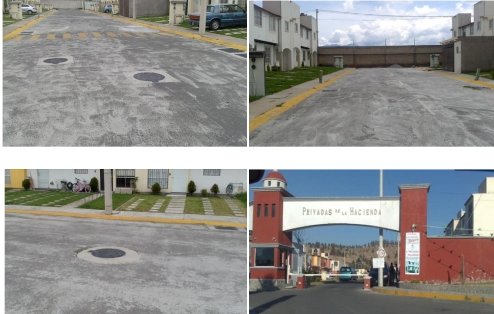
Imagen N.º.9. Servicio de red de drenaje y alcantarillado en “Privadas de la Hacienda”
