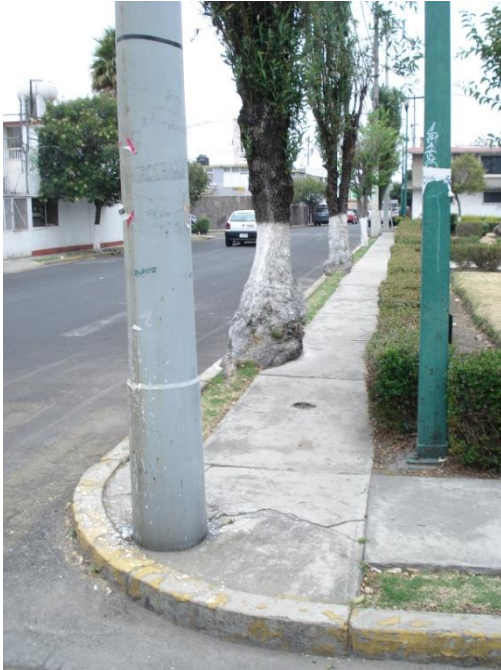
Ilustración 5 Obstrucción a la circulación por equipamiento urbano
