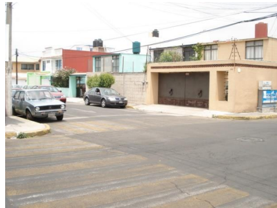
Ilustración 8 Falta de rampas en esquinas
