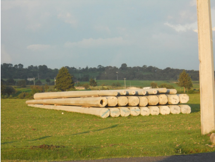
Foto 36. Fuente elaboración propia. Postes para instalación de tendido de cables. Ruta mazahua, km 102 o “el 102” como se le conoce, junio de 2011.jpg
