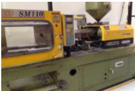
Figura 33. Instalación eléctrica de máquina-carga
