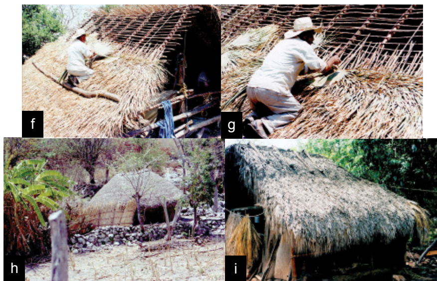
f,g) construcción del techo, h,i) dos chozas de palma en San Gaspar, Zumpahuacán, Estado de México (Luis Miguel Vázquez García).
