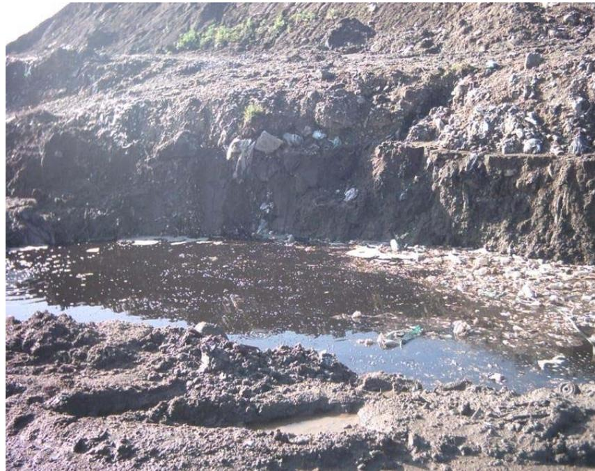
**Figura 4.9** Fotos panorámicas de las lagunas de lixiviado que se forman en la franja norte de la periferia del vertedero de Metepec.
