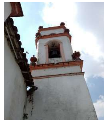
Fotografía 13 Inclinación y separación Fuente: Propia del campanario Recuperado: 26/07/2023 con la nave
