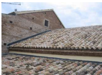
Imagen 38 Cubierta de la Iglesia Fuente: Lavila Arquitectos Recuperado: 13/10/2023
