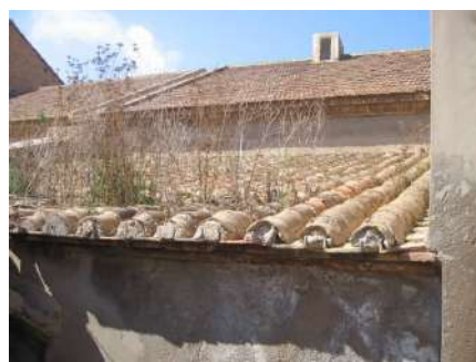
Imagen 37 Tejado de la Iglesia Fuente: Lavila Arquitectos Recuperado: 13/10/2023
