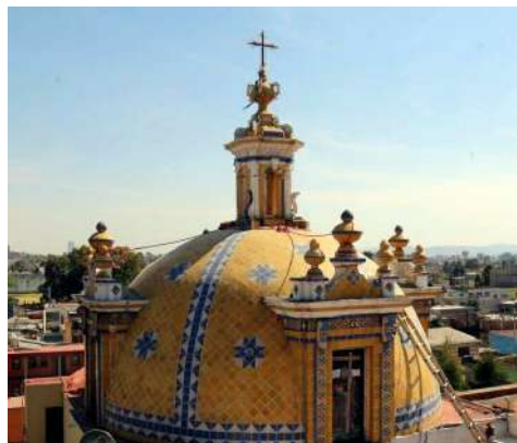
Imagen 24 Cúpula Fuente: Municipios Puebla Recuperado: 13/10/2023 https://municipiospuebla.mx/nota/2017-12-05/sanandr%C3%A9s-cholula/habitantes-reparan-iglesia-da%C3%Blada-por-sismo-en-tonantzintla
