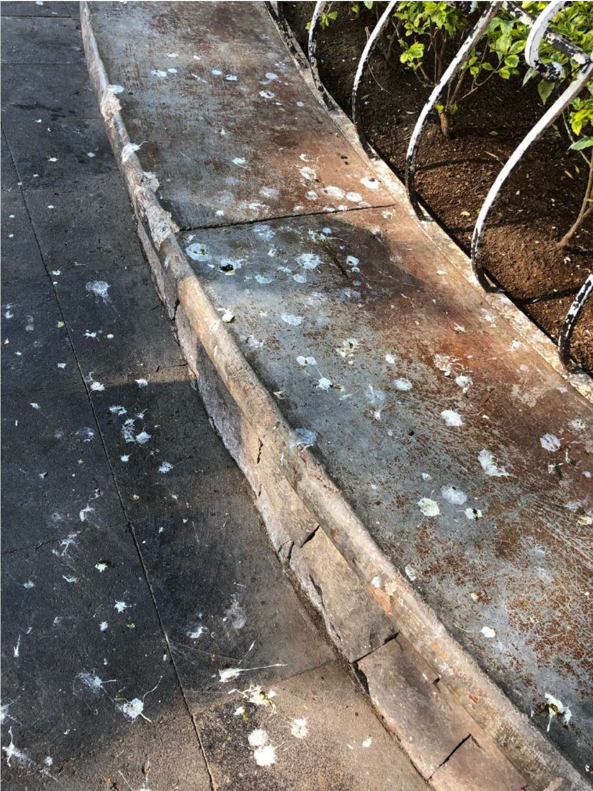
Desechos orgánicos generados por plaga aviar. Jardín Morelos, Tenancingo Méx. Fotografía de autoría propia.
