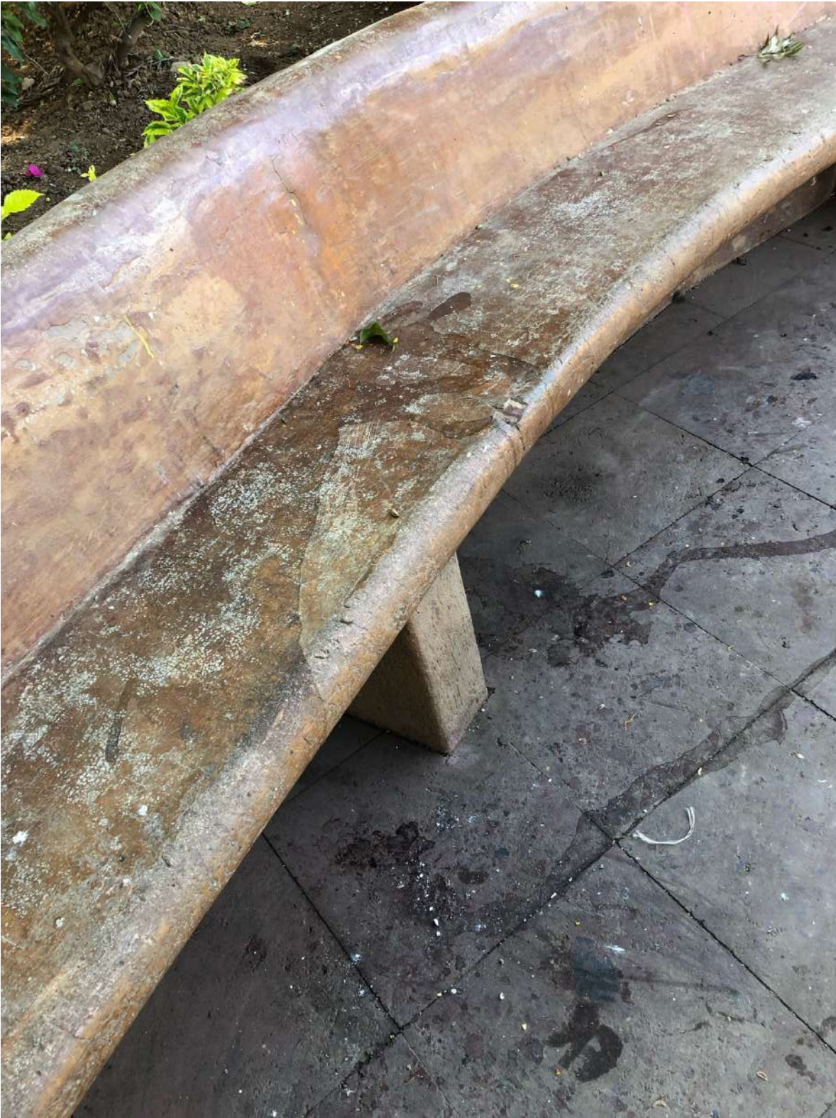
Falta de atención y limpieza. Jardín Morelos, Tenancingo Méx. Fotografía de autoría propia.
