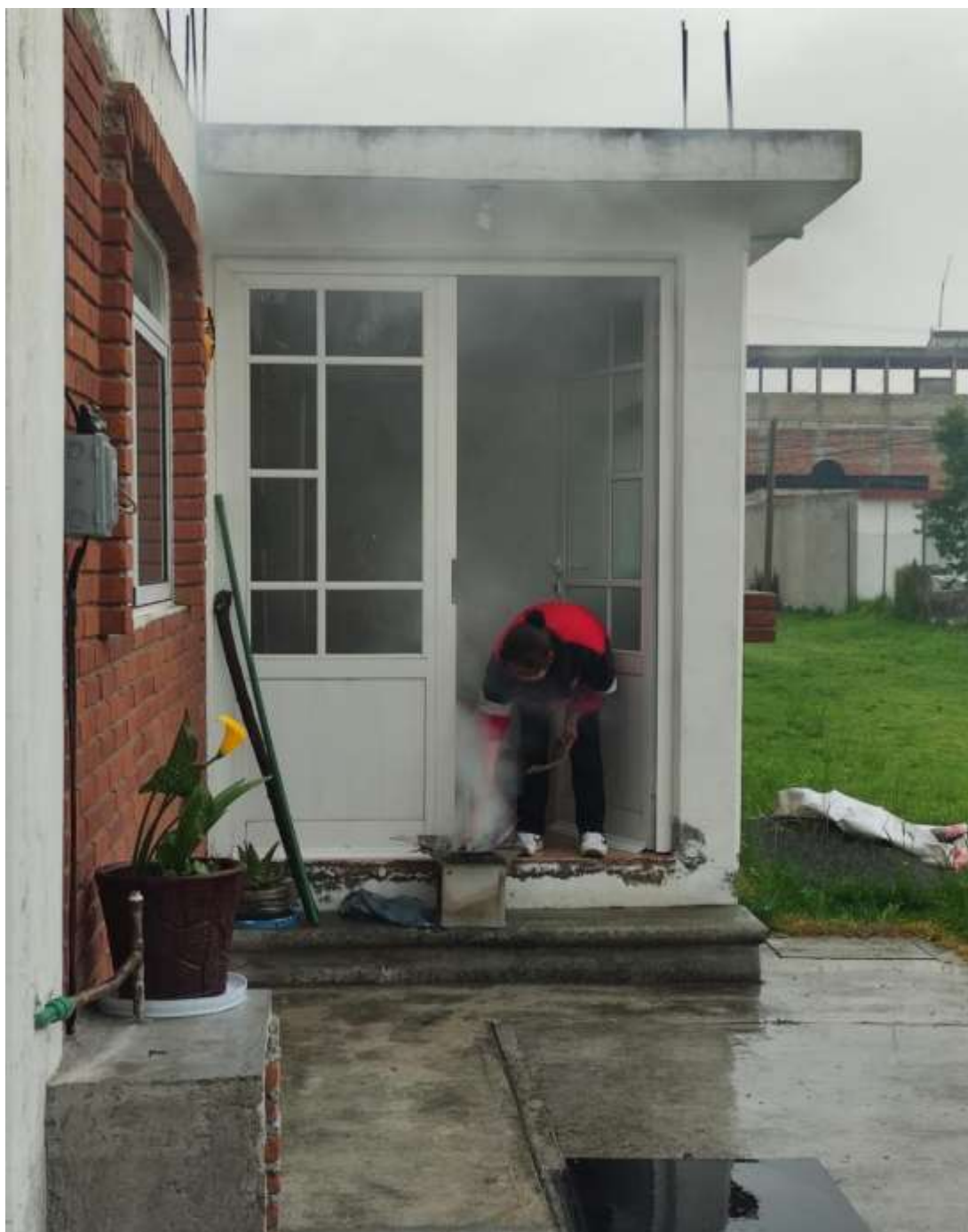
Foto 81. La señora Juana González colocando el bracero en puerta de la entrada principal (trabajo de campo, 2023).
