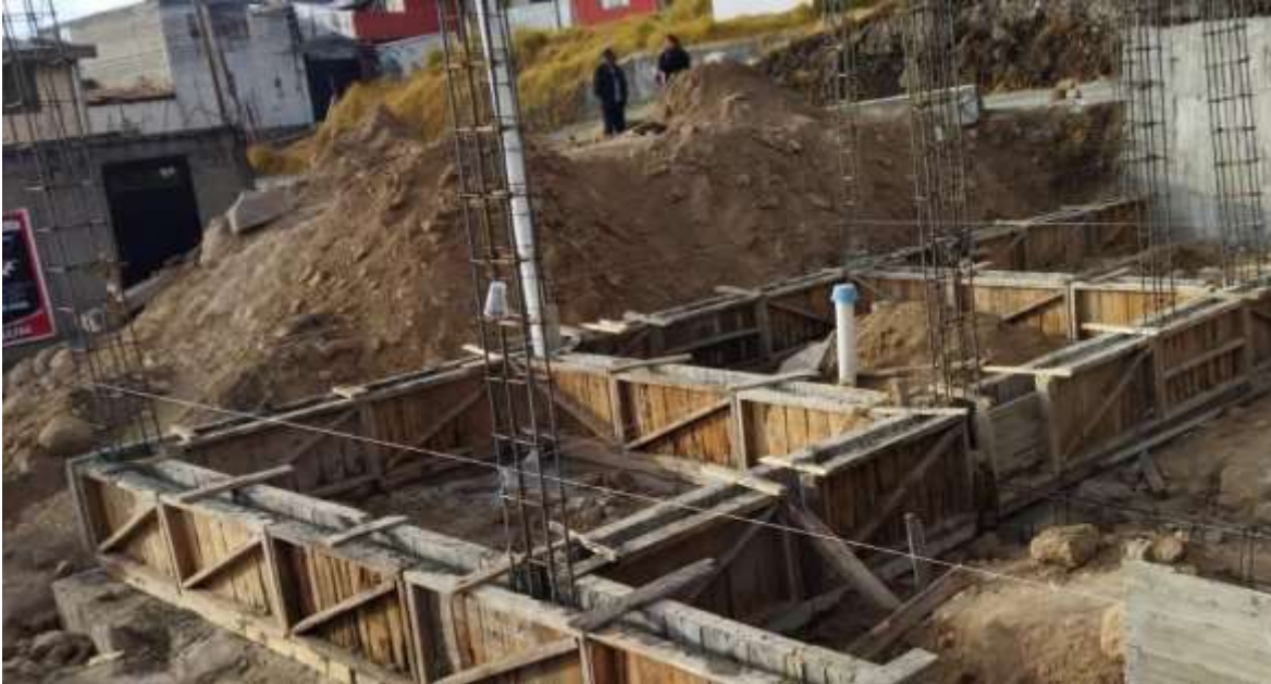
Foto 58. Cimientos de la casa en construcción de la señora Edith Mercedes Reyes (trabajo de campo, 2022).
