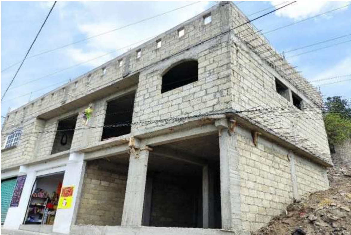
Foto 56. Casa en construcción de la señora María Guadalupe González González (trabajo de campo, 2022).
