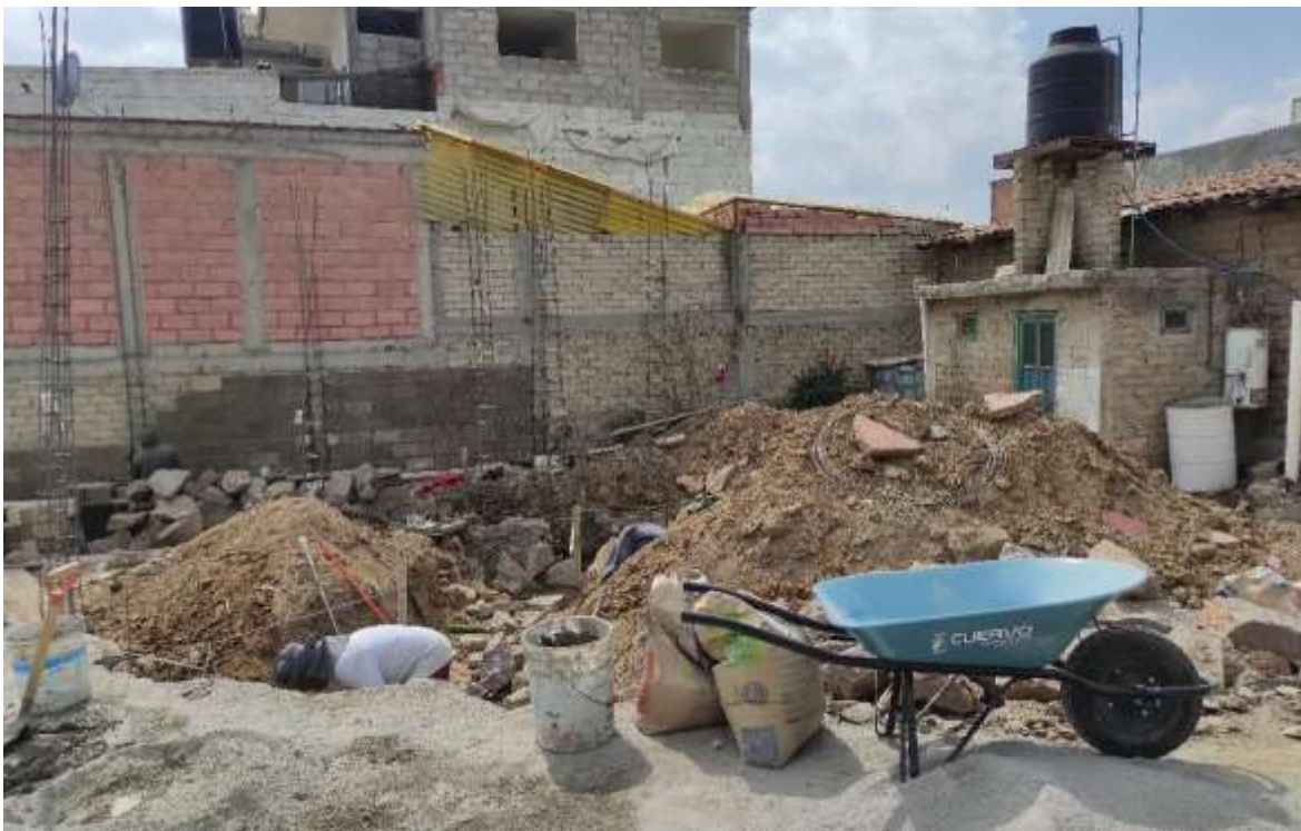
Foto 57. Casa en construcción del señor Rodrigo Bernal (trabajo de campo, 2022).
