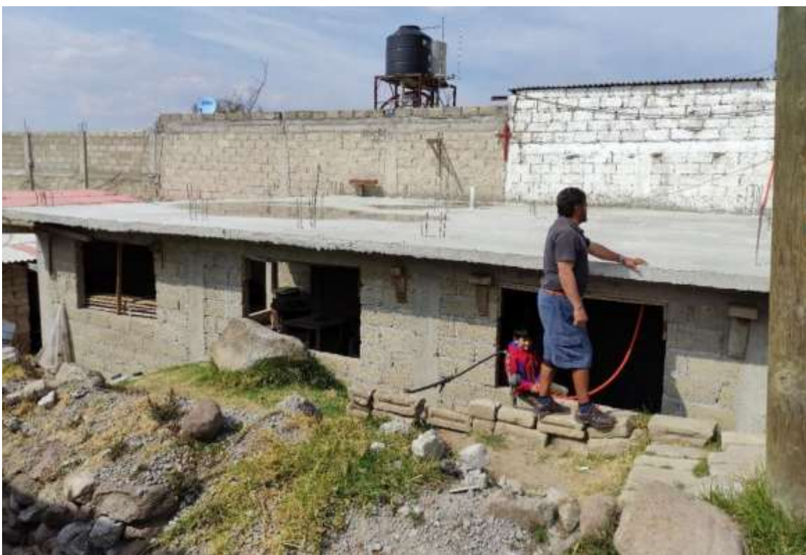
Foto 55. Casa en construcción del señor Ernesto Pichardo (trabajo de campo, 2022).
