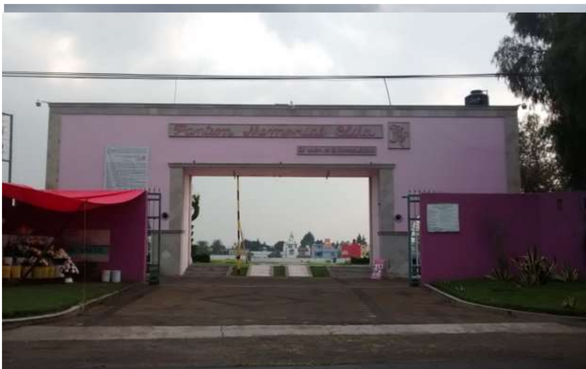
Ilustración 18 Panteón municipal privado de Texcoco, fotografía sacada de la red
