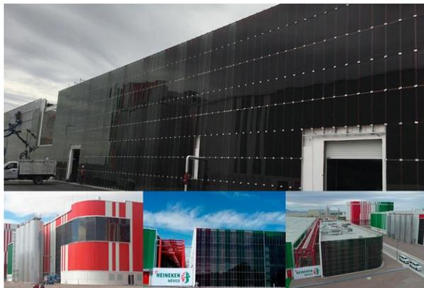
**Figura 52.** Fachadas de la planta Heineken cubiertas de vidrio fotovoltaico que genera energía limpia mediante el sol. (Eseficiencia, 2018)
