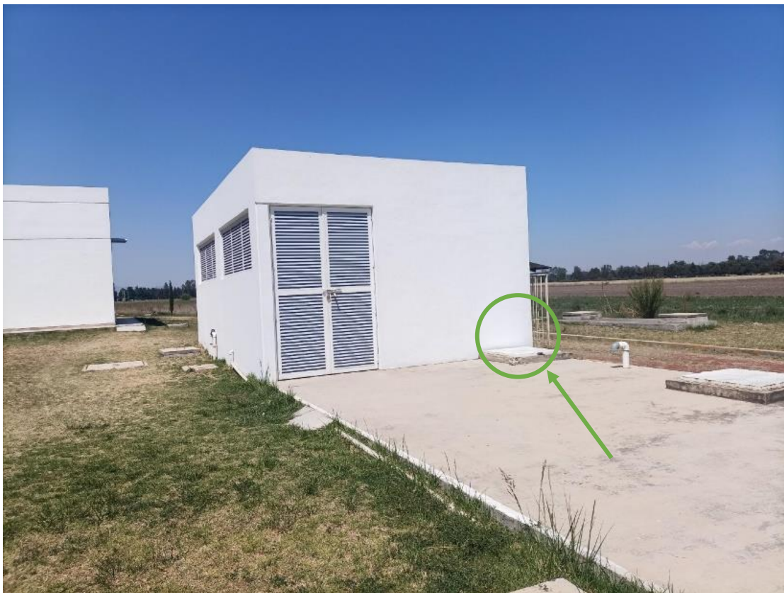
Figura 1. Planta purificadora de agua de lluvia por fuera
