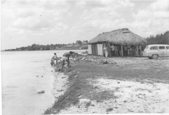
Figura 4. Construcción del Balneario ejidal.
