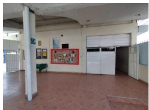
Fig. 21-24 Acceso-salida. Interferencias visuales y físicas. Nudo en origen que incumple con informar y direccionar.
