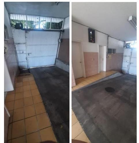
Ilustración 44 Imagen que muestra el acceso peatonal y las barreras presentes (fuente propia).
