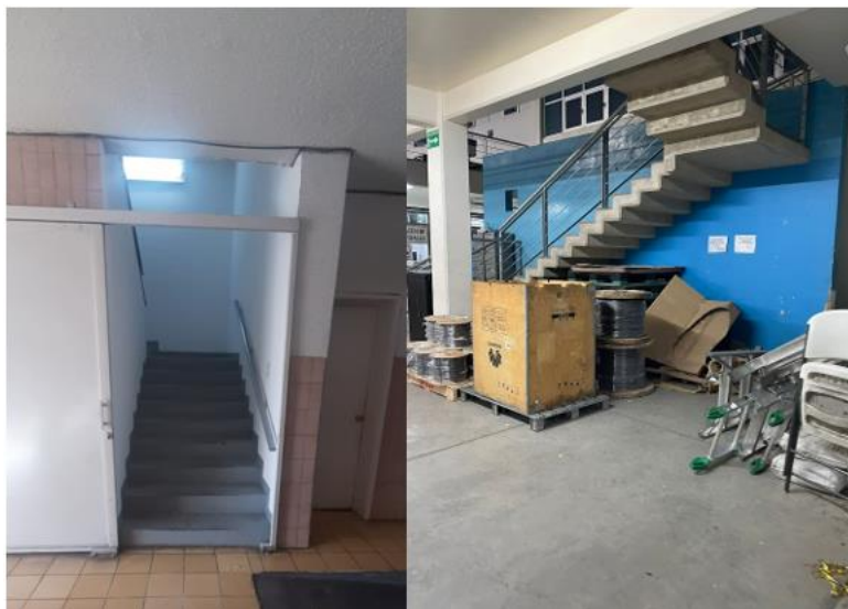
Ilustración 67 De lado derecho se observa la escalera que se encuentra cerca de la entrada principal, del lado derecho se muestra la escalera ubicada cerca del almacén, también se muestra el bloqueo con materiales para acceder a la rampa (fuente propia).
