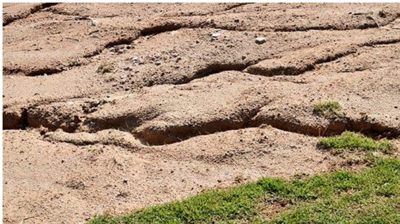
Figura 4. Erosión en canales y canalillos
