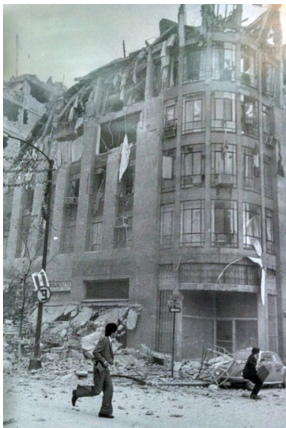
Fotografía 1. Edificaciones destruidas durante los sismos de septiembre de 1985 en la Ciudad de México
