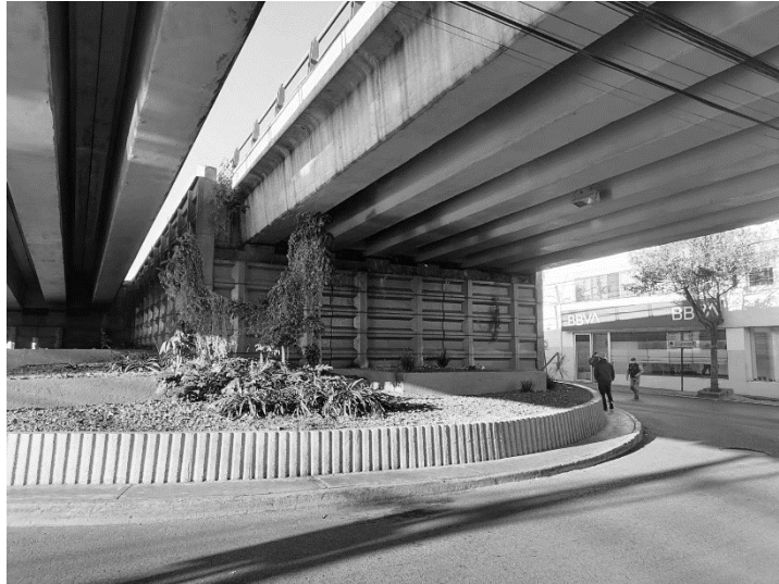
Figura 3.6. Imagen de los apoyos de tierra armada.
