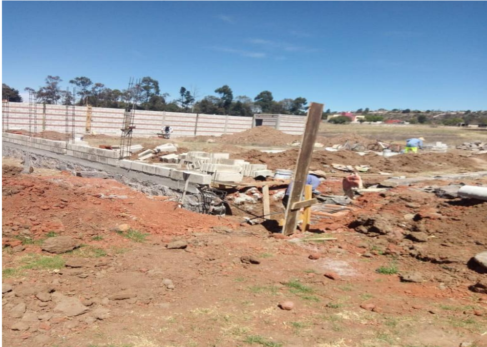
Fotografía No. 5. Inicio de Construcción de Bodega de Almacenamiento en Santiago Acutzilapan.
