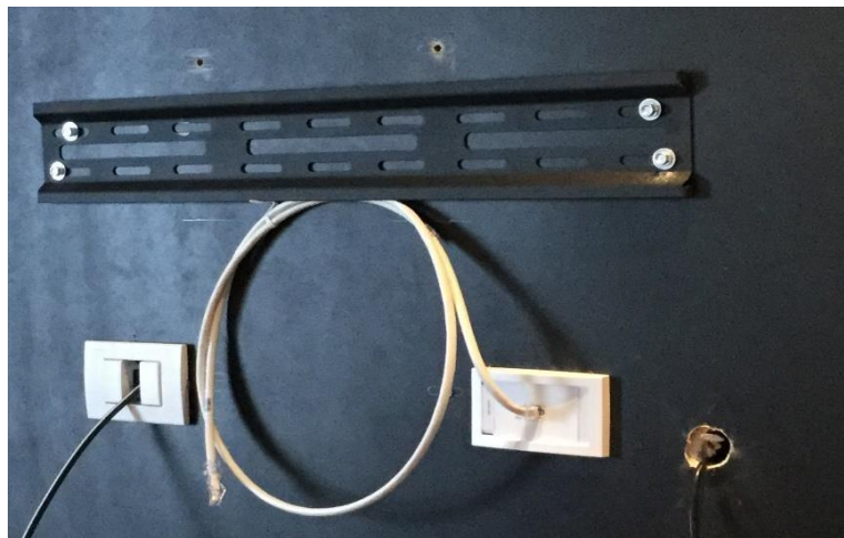
Figura 57. Base y conexiones listas (Edición propia)
