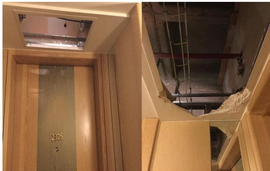
Figura 49. Retiro de plafones y colocación de escalerilla (Edición propia)
