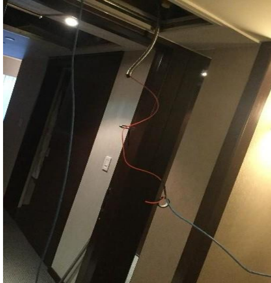
Figura 51. Colocación de tubo flexible dentro de la habitación (Edición propia)
