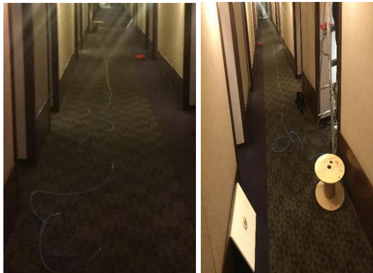
Figure 50. Tendido de cable en pasillo (Edición propia).
