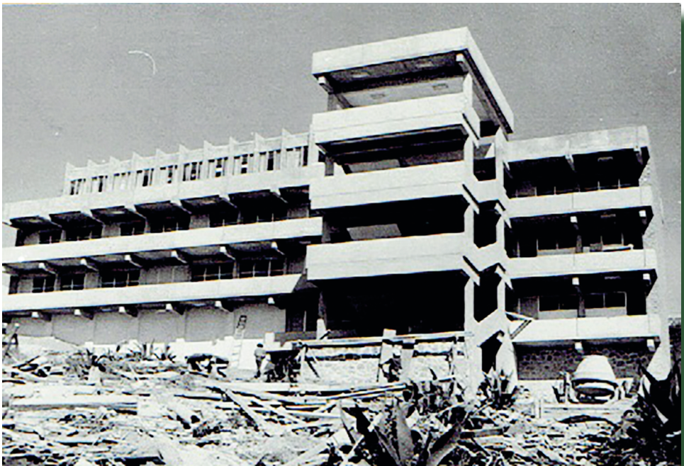
Torre de Humanidades en Ciudad Universitaria (en construcción).
