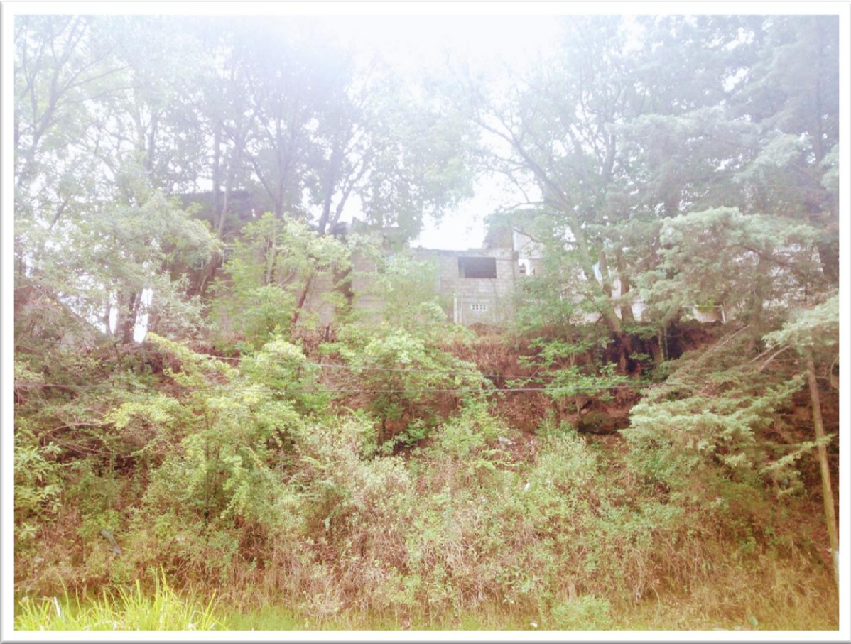
Figura 11. Deslizamiento en la localidad de San Pedro Arriba.
