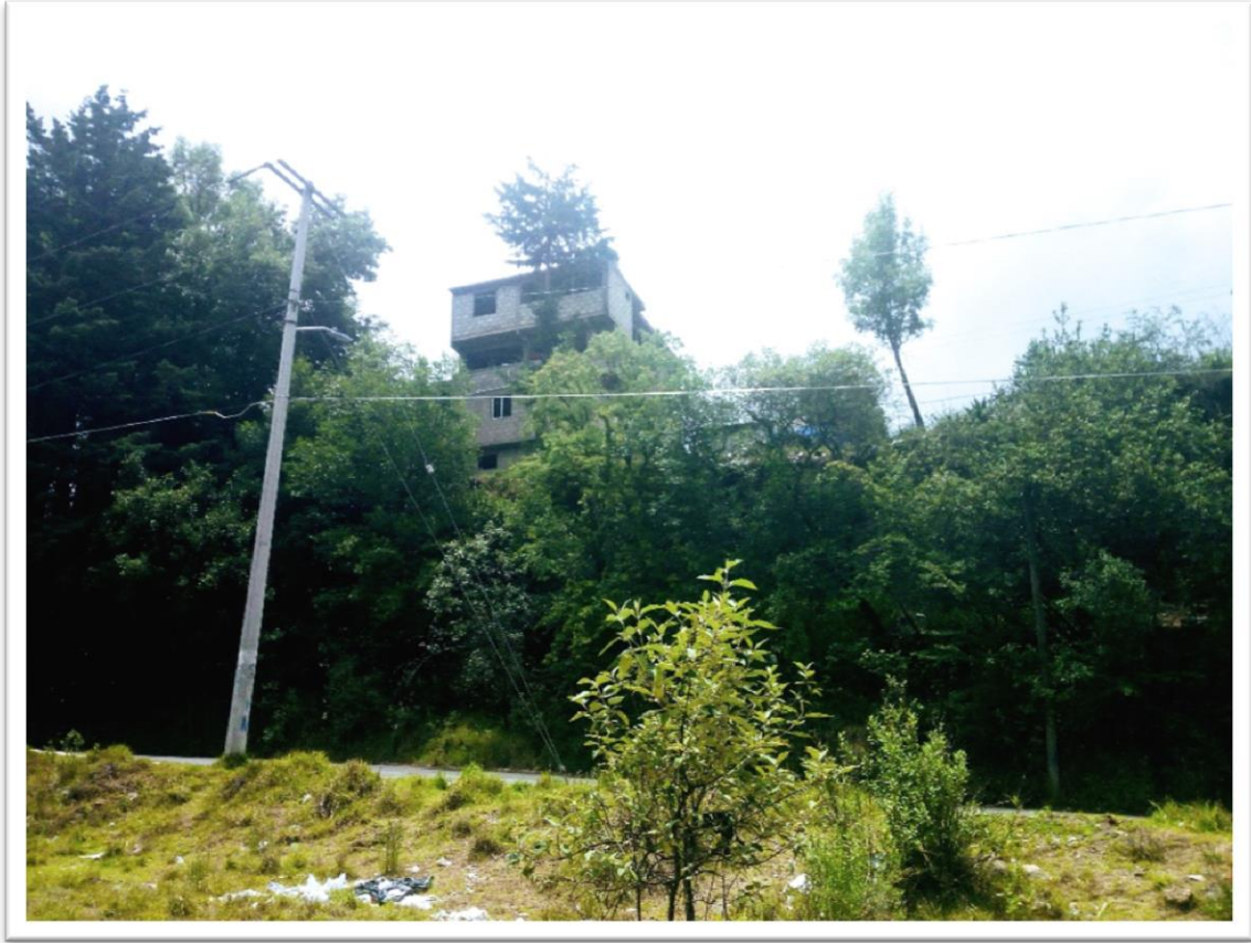
Figura 9. Posible deslizamiento ubicado en la localidad de San Pedro Abajo.
