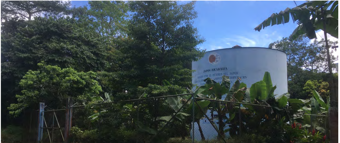
Tanque Enacal Sector El Tanque 17.10.20
