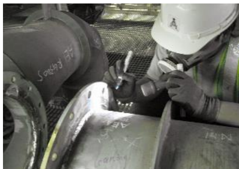
Figura 8. Inspección visual de soldadura.
