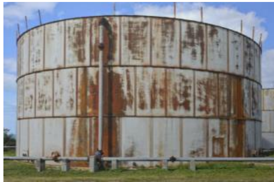
Figura 9. Exceso de soldadura en juntas de placas en envolvente.
