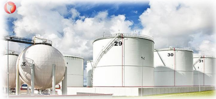
Figura 1. Ejemplo de RSP como tanques de almacenamiento en su forma cilíndrica y esférica.
