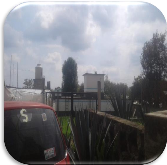
Imagen 4: Tanque de almacenamiento San Francisco II
