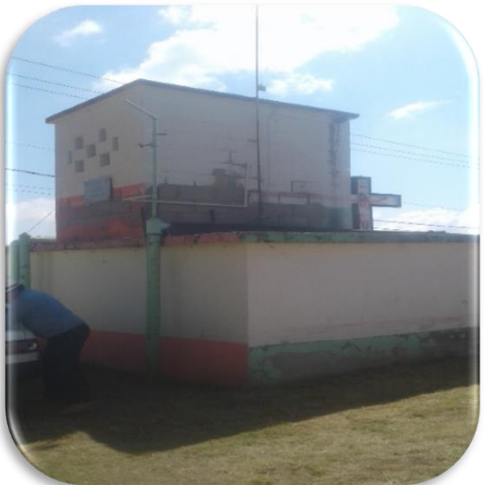
Imagen 3: Tanque de almacenamiento los Fresnos
