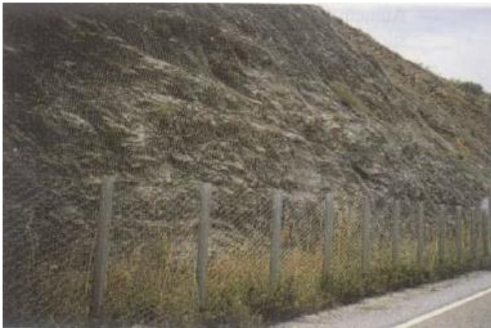
Figura 5.10. Ejemplo de uso de mallas metálicas. Foto tomada M. Ferrer en González de Vallejo (2002).
