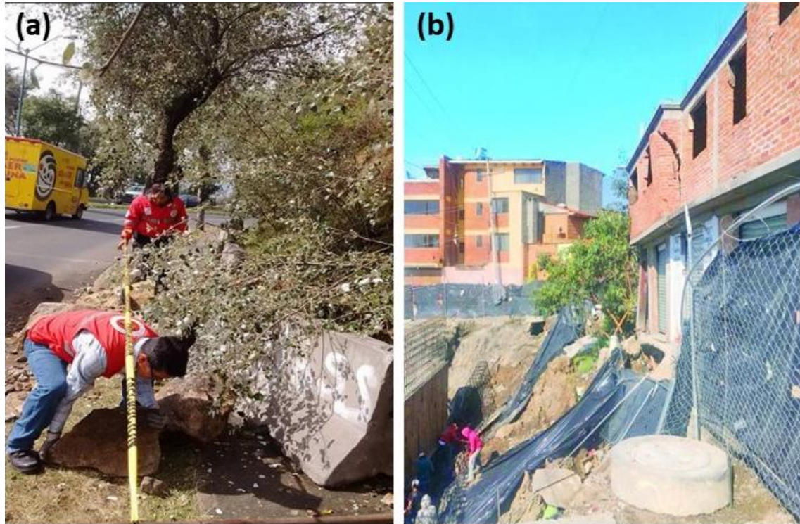
Figura 1. Impacto de los movimientos gravitacionales sobre la infraestructura en el área de estudio: a) Caída de bloques sobre el Paseo de los Matlazincas. b) Talud en la zona de la Teresona construido para ubicar una gasolinera, provocando serios agrietamientos en las construcciones adyacentes.
