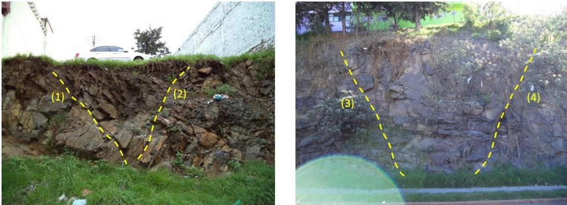
Figura 4.13. Deslizamientos en forma de cuña ocurridos en el pasado, el cuerpo del deslizamiento estuvo delimitado por planos de fallas (línea discontinúa amarilla) que según su dirección de buzamiento y ángulo de buzamiento se intersectan. (1)295°/71°, (2)025°/68°, (3)215°/75° y (4) 043°/68°.
