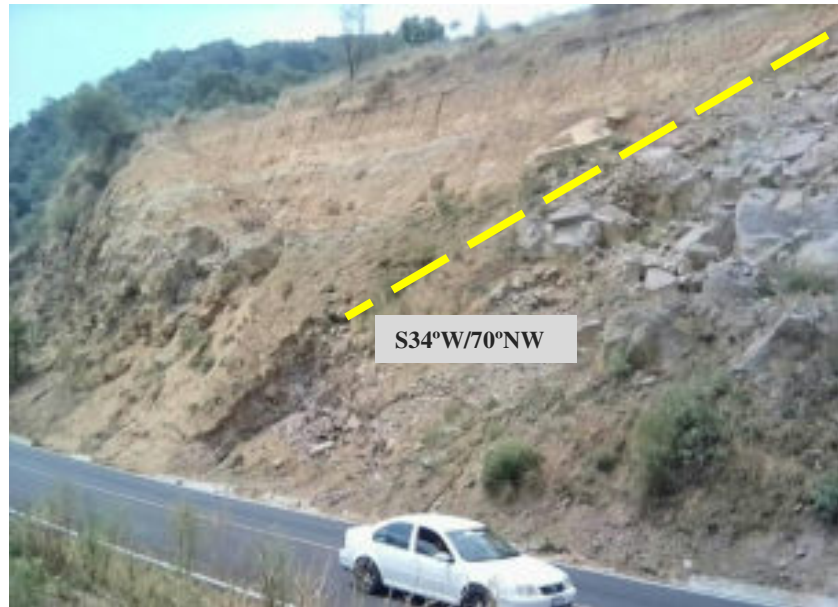
Figura 4.26 Fractura con orientación NE-SW con bloques rotados de roca andesítica del Complejo de domos Santa María Jajalpa.
